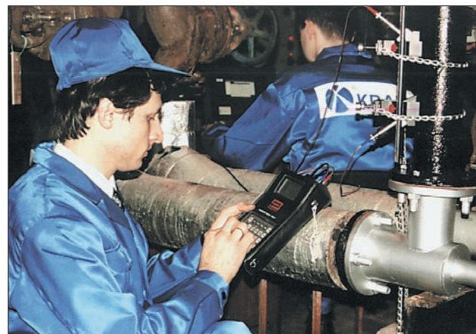
Пусконаладочные работы на одном из объектов «Кварка»
